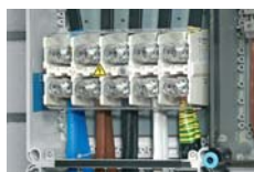
Клеммы для подходящих/отходящих линий в разделе Комплектующие
