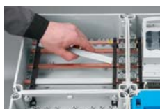
Изолирующий кожух для токоведущих шин
